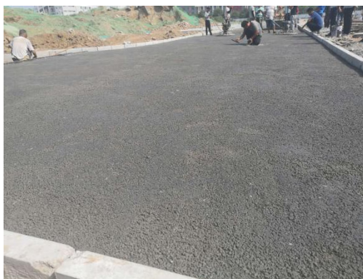
南区道路施工
