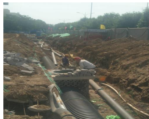
室外管线施工
