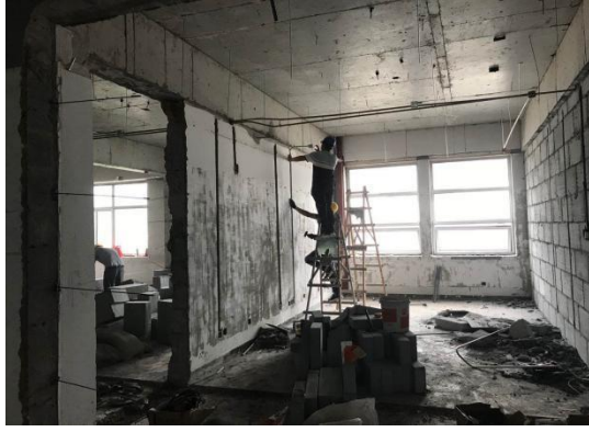
三层隔墙砌筑
