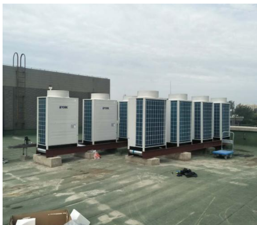
空调室内外安装
