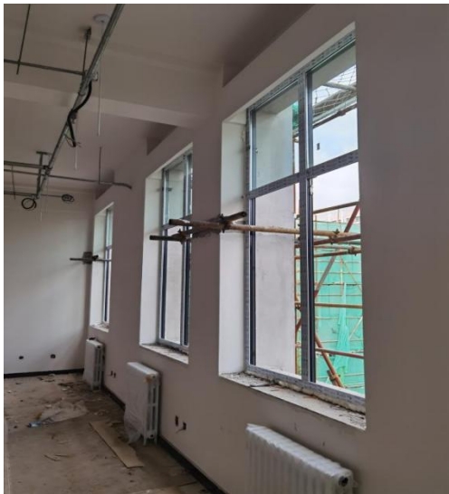
南段外窗玻璃安装
