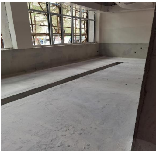
南段 1 层实验室防水施工
