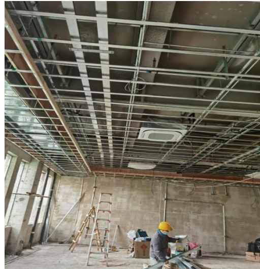
北段 4 层吊顶龙骨施工
