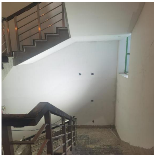
南段 1-4 层内墙刮第二遍腻子
