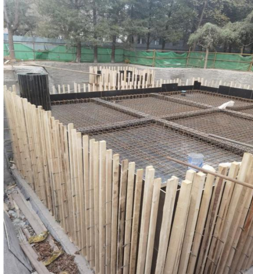
消防水池施工
