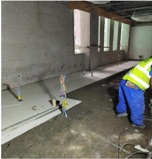
南中北段 2 层地砖施工
