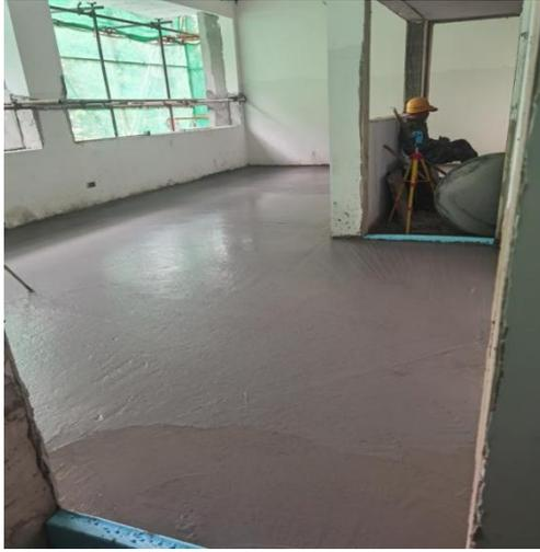
南段 2、4 层 PVC 地面垫层施工
