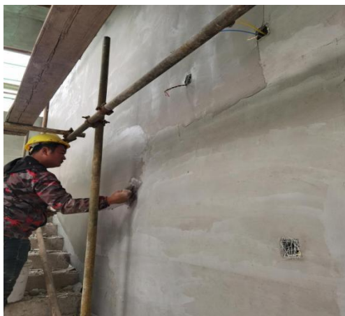
南段外墙保温腻子施工
