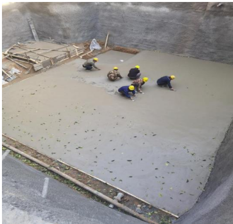
消防水池垫层施工
