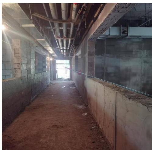
南段 1 层墙面施工
