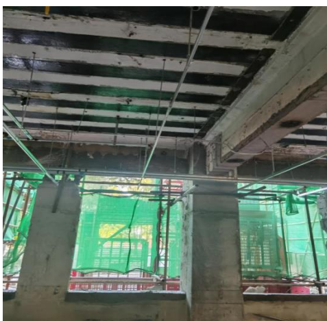
中段 1 层窗口施工
