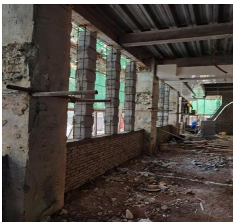
北段 1 层外墙砌筑
