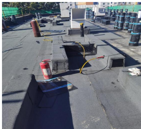
南段屋面防水施工
