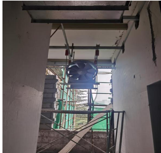
中南段风机安装
