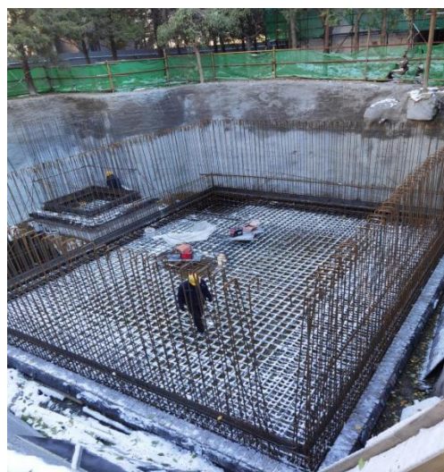
消防水池施工
