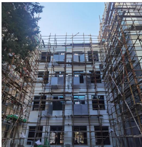
中段 2-4 层外墙东立面施工
