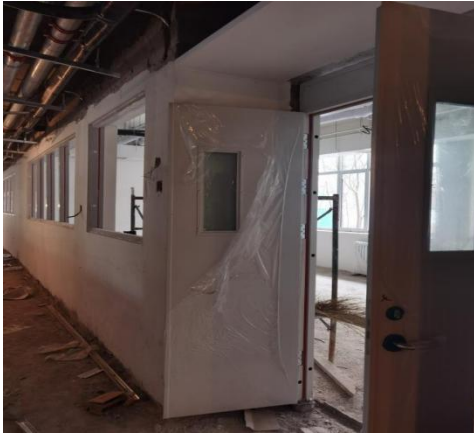
南北段 1-4 层防火门安装
