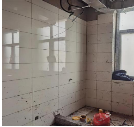
南段 2-4 层卫生间墙地砖施工
