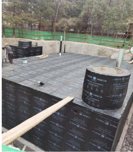
北段 4 层地砖及报告台施工 室外消防水池防水卷材施工
