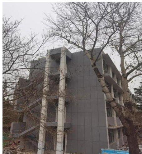
南段室外东西楼梯喷真石漆
