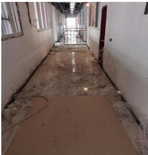
南段 3-4 层走廊地砖施工
