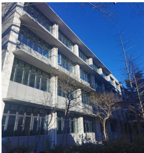
南段 1-4 层开启扇及玻璃安装
