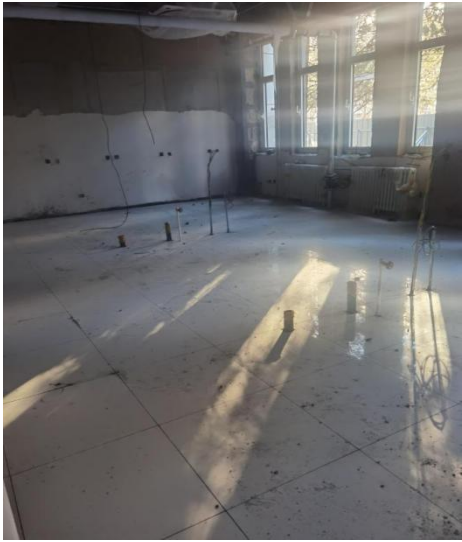
北段 1 层地砖施工
