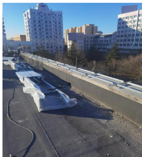
南段屋面女儿墙铝扣板施工
