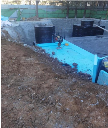
室外消防水池土方回填
