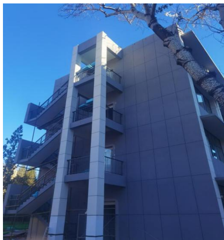
南段室外楼梯栏杆
