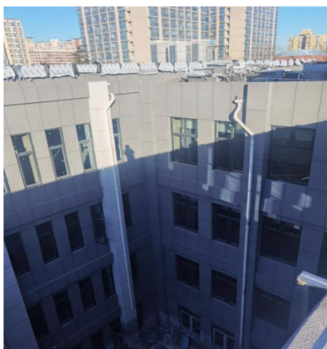
中段 2-4 层外墙西立面施工
