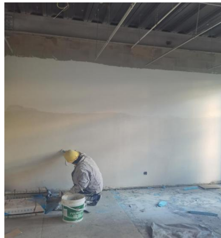
北段 1-2 层墙面刮腻子
