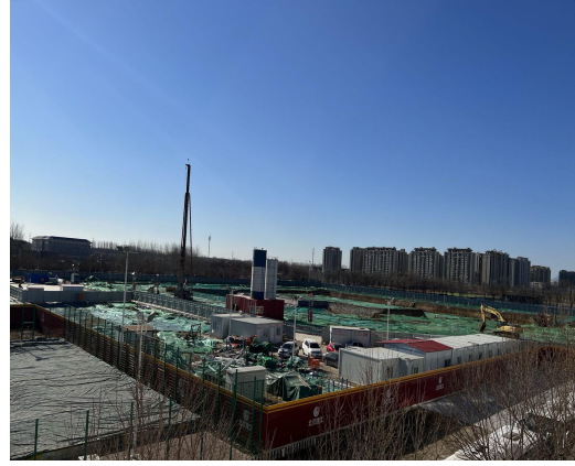
止水帷幕施工
