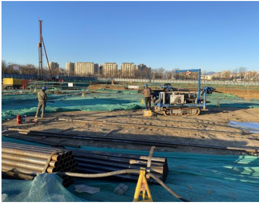
钢管桩施工
