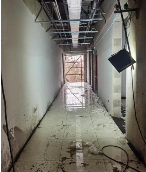
北南段 3 层地砖施工
