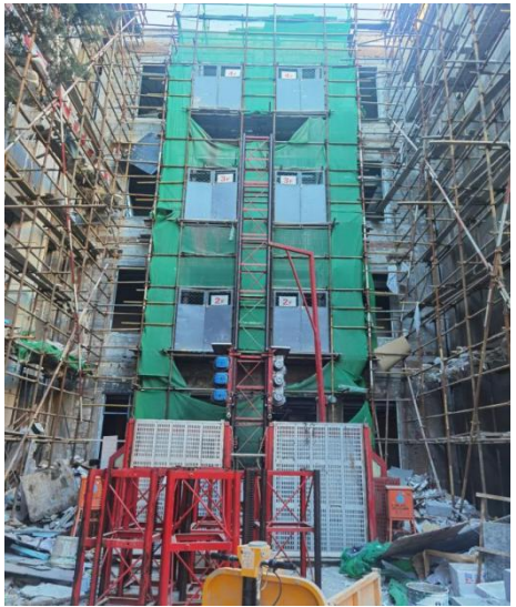
中段外电梯拆除
