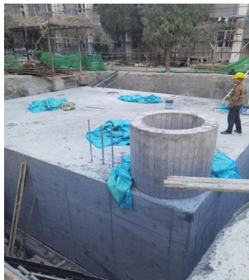
消防水池施工
