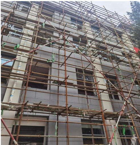
南段1-4层开启扇及玻璃安装
