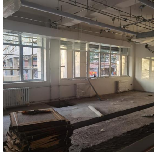
南段暖气及管安装
