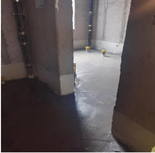
南段 1 层卫生间防水保护层施工
