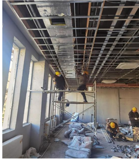
北段 4 层喷淋、排风保温施工
