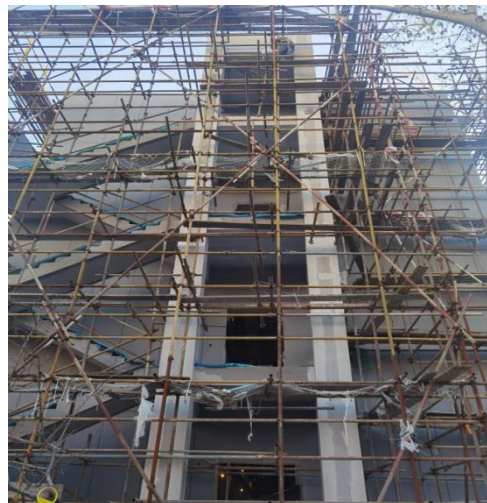
南段室外楼梯施工
