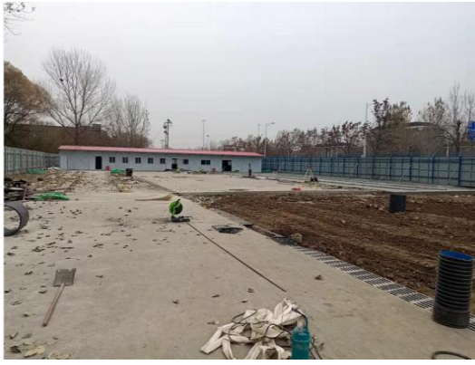
生活区路面硬化
