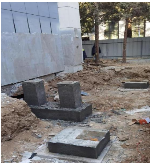
室外钢梯基础施工
