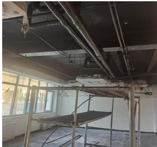
南段 1 层墙面及顶棚涂料施工
