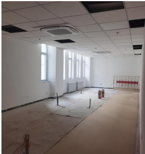
北段 2-3 层墙面涂料施工
