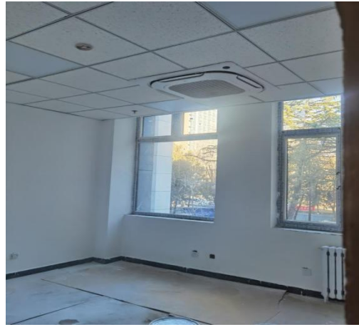
中段 2-4 层墙面涂料施工
