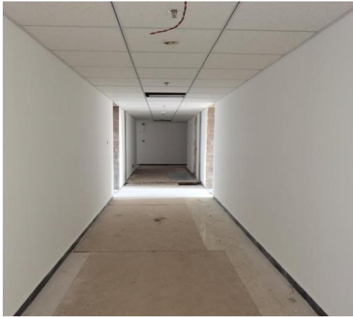
中段 2-3 层走廊吊顶安装
