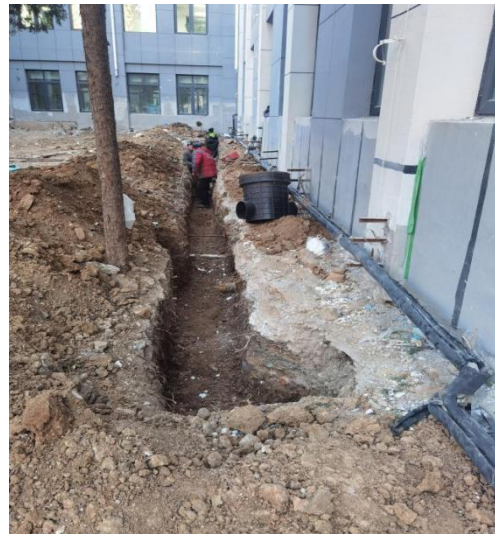
室外排水管沟开挖
