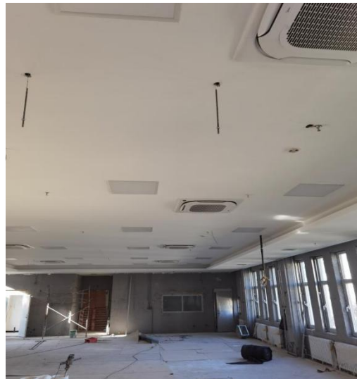
北段 4 层室内施工
