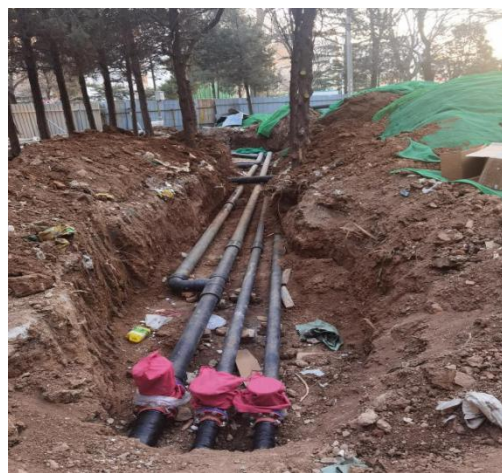
室外消防管安装
