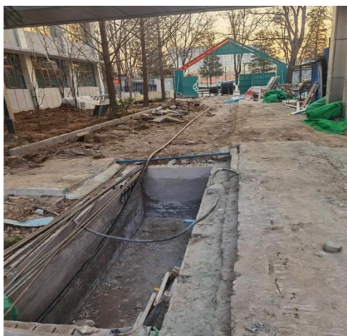
室外电缆穿管
