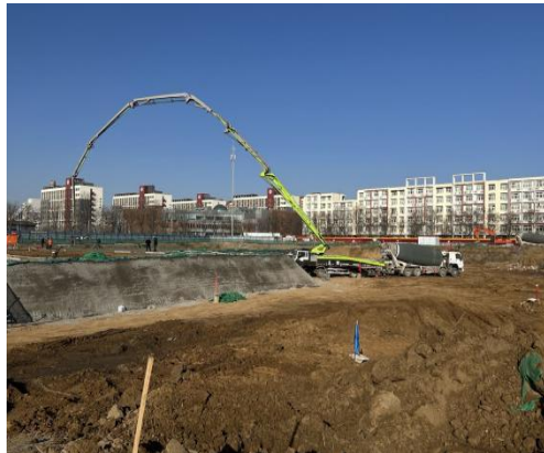
护坡喷锚施工
