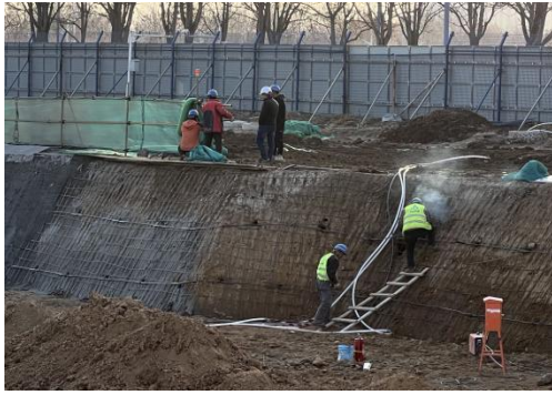
护坡钢筋网片施工
