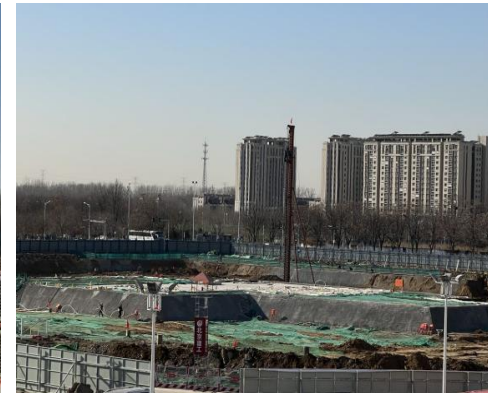
CFG 桩施工
