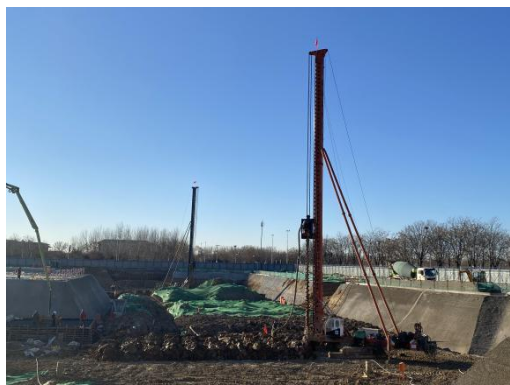
CFG 桩施工
