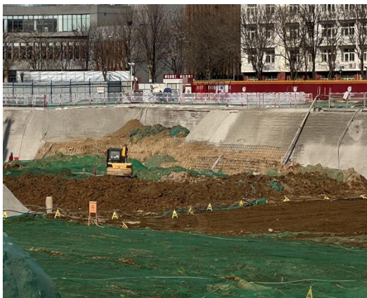
护坡钢筋网片施工
