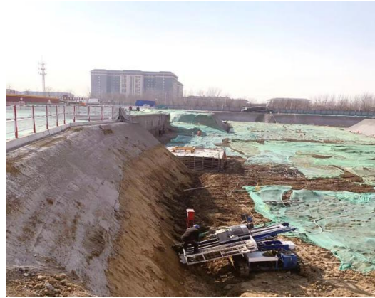
土钉钻机施工（钻孔）
