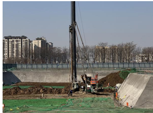
CFG 桩施工
