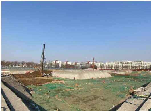
CFG 桩施工
