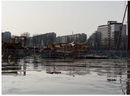
塔吊部件进场
