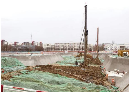
CFG 桩施工
