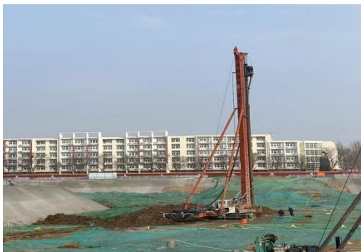
CFG 桩施工
