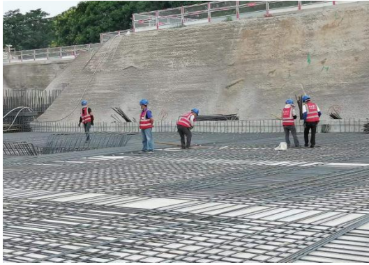
钢筋绑扎施工
