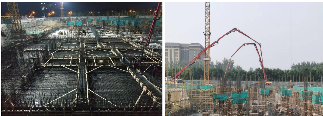
混凝土浇筑
