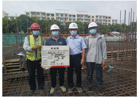
钢筋绑扎验收
