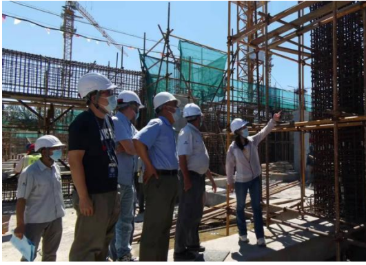
区建设工程安全监督站现场检查
