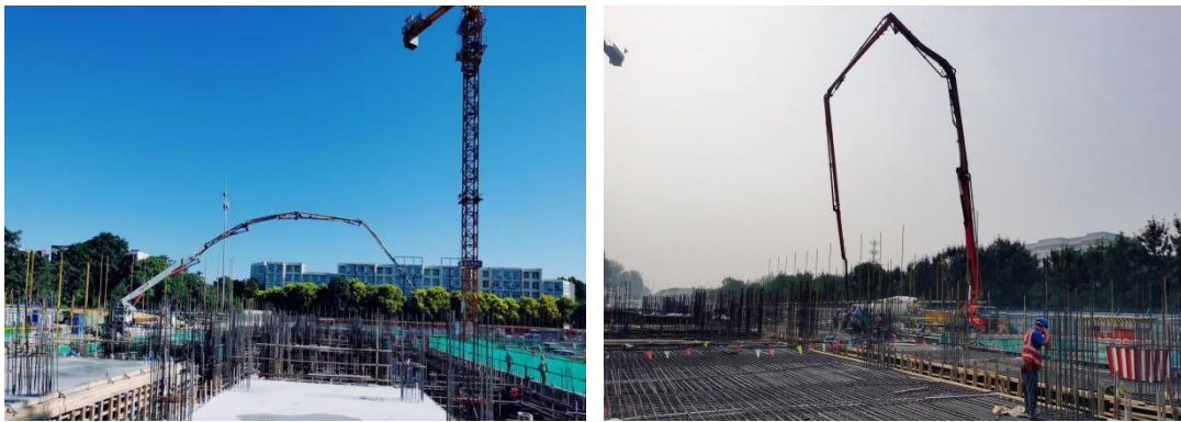
混凝土浇筑
