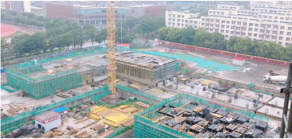
A 座首层施工
