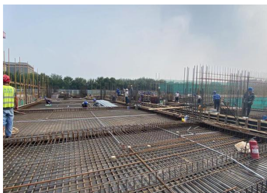
顶板钢筋绑扎
