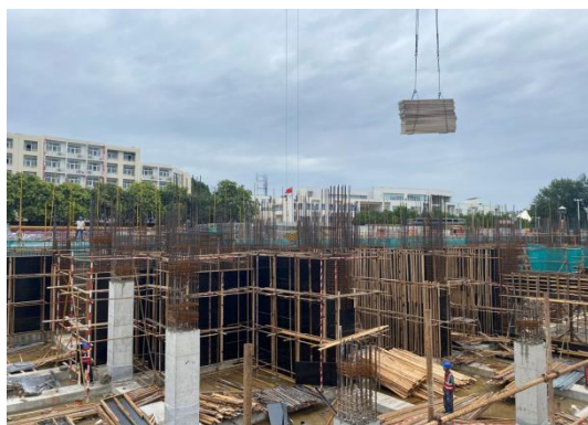
地下室竖向墙体模板施工
