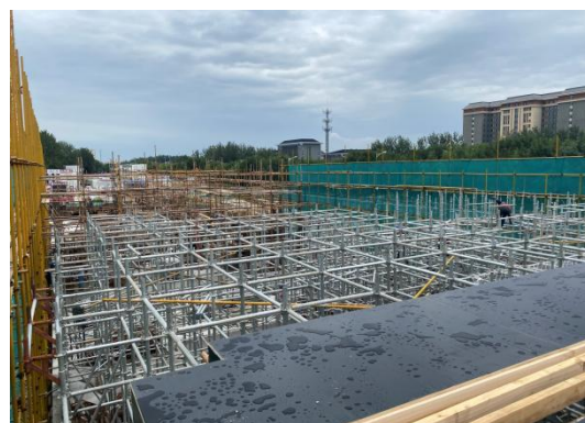
地上首层顶板支撑体系施工
