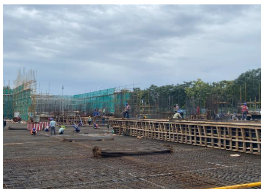
顶板钢筋绑扎、模板施工
