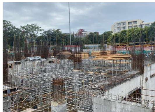
顶板支撑、模板施工
