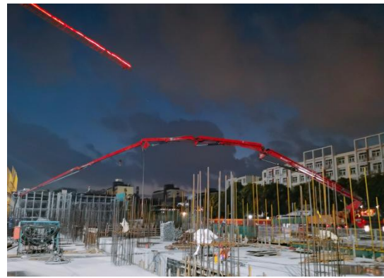
混凝土浇筑
