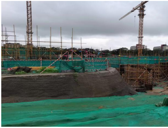
脚手架施工
