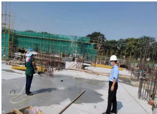
现场洒水养护
