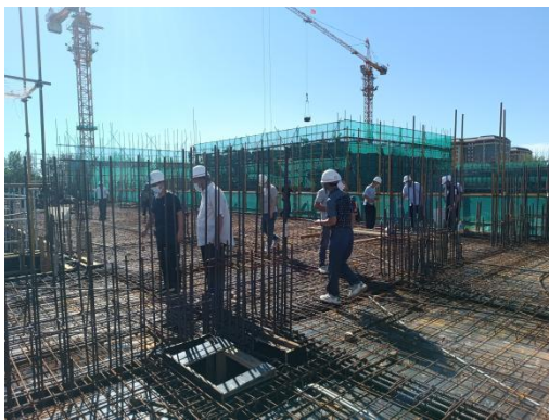
A 座 2 段首层顶板检查
