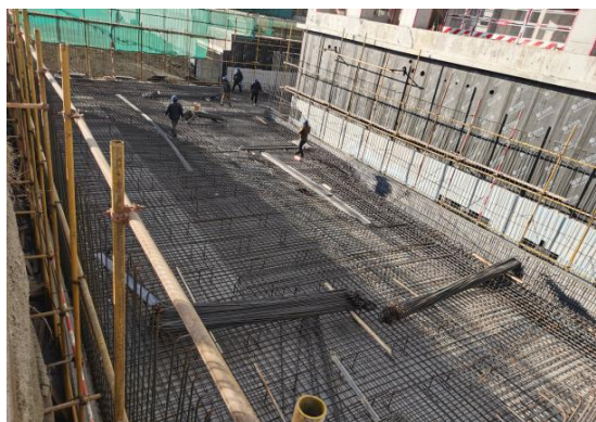
消防水池施工
