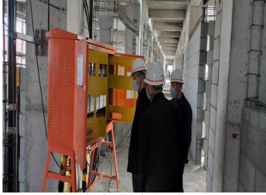
临电安全检查
