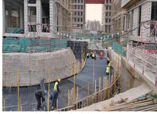
汽车坡道结构施工
