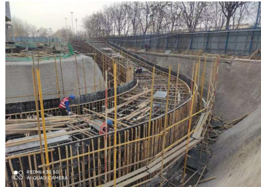
汽车坡道结构施工
