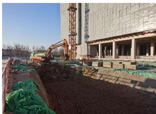
汽车坡道施工
