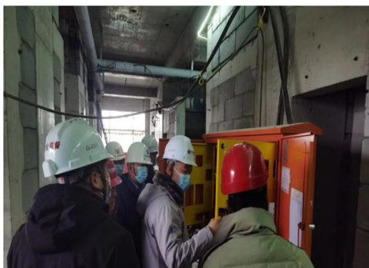
临电安全检查
