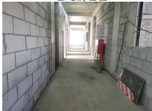
二次结构砌筑
