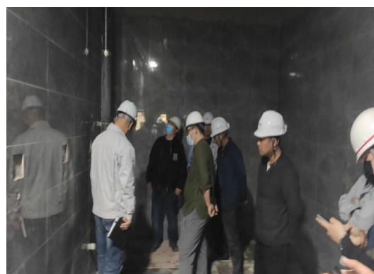
卫生间样板施工
