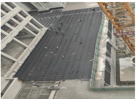
地下室顶板防水
