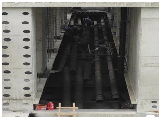
机电专业施工
