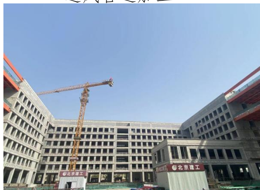
埋件打孔安装
