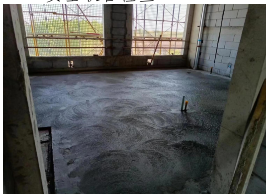
地面垫层施工
