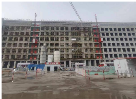
外脚手架拆除
