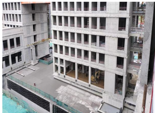
房心回填土施工
