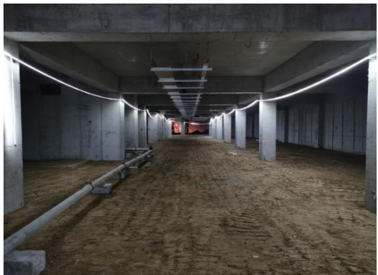
地下室垫层施工
