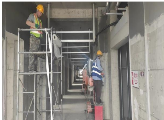
走廊装饰施工
