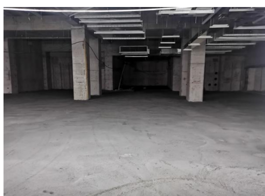
地下室垫层施工
