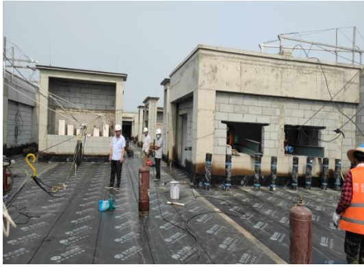
屋面防水施工
