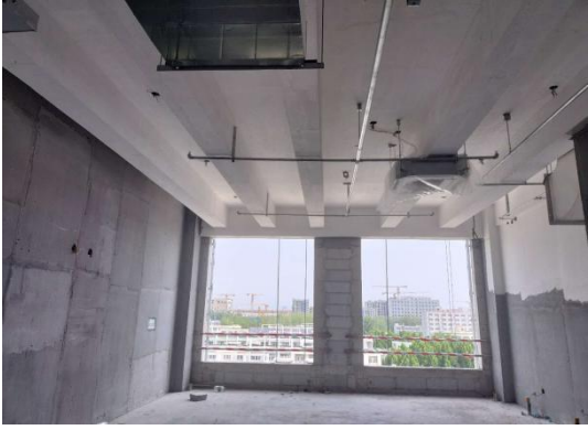
室内装饰施工
