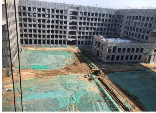
室外管线施工
