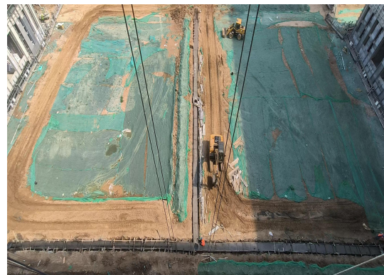
室外管线施工
