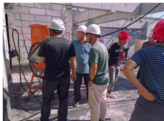
临电安全检查
