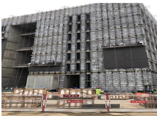
陶板幕墙施工
