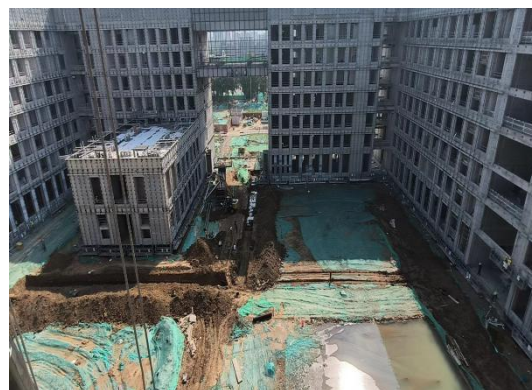
室外管线施工
