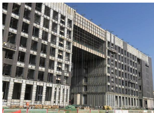
陶板幕墙施工
