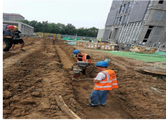
室外管线施工
