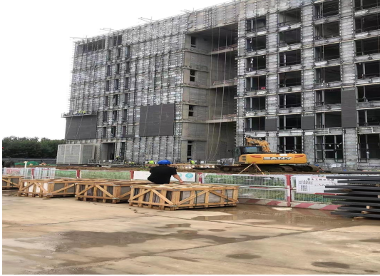
陶板幕墙施工
