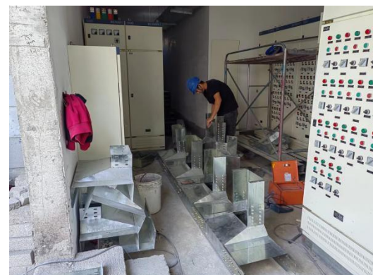
机电专业施工
