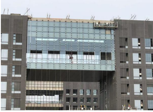
玻璃幕墙施工
