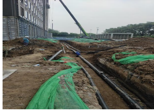
室外管线施工
