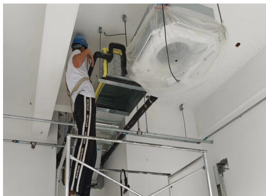
机电专业施工
