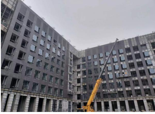
陶板、外窗施工
