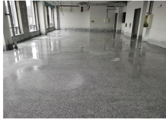
水磨石地面施工
