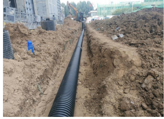
室外管线施工
