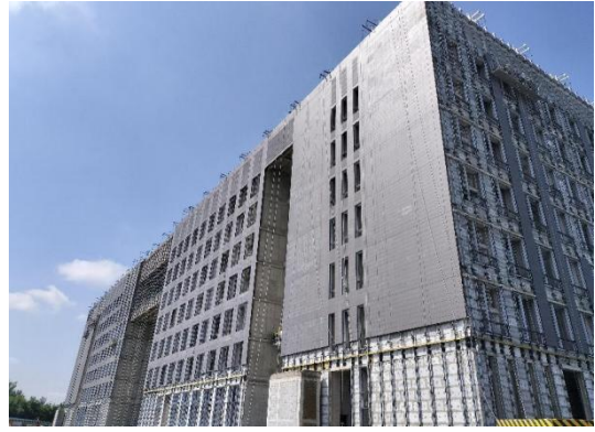
陶板幕墙施工
