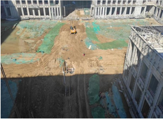
室外管线施工
