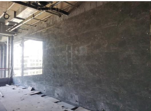
卫生间砖铺贴
