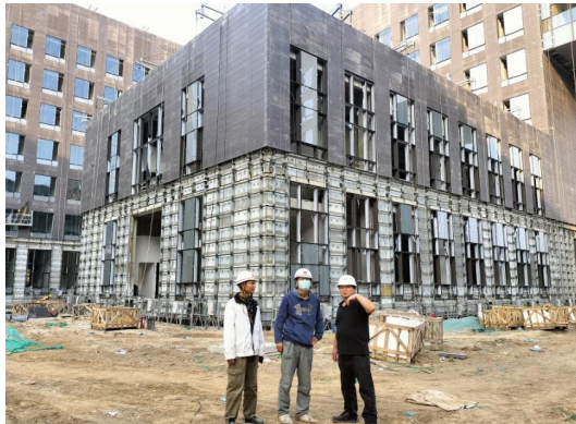
陶板幕墙施工
