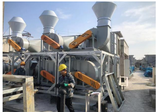
机电专业施工
