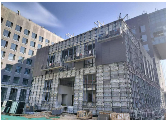
陶板幕墙施工
