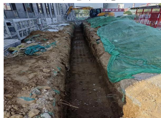
室外管线施工
