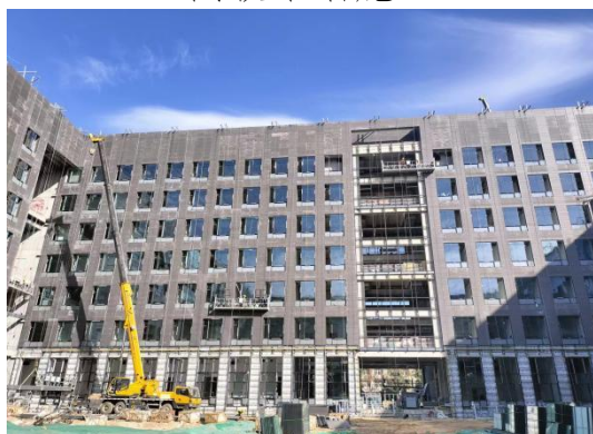
玻璃幕墙施工
