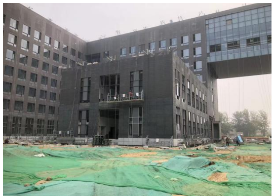
陶板、石材施工
