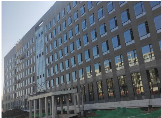
玻璃幕墙、雨棚施工
