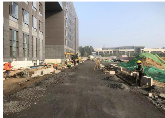
室外工程施工
